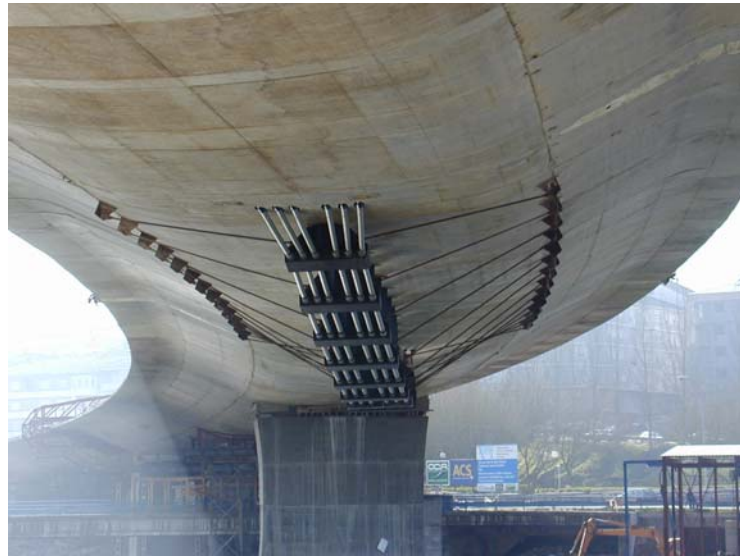
Pretensado extradorsal inferior
