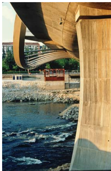
Vista del fondo del tablero
