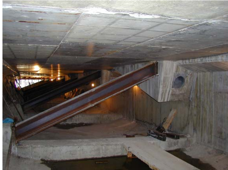
Traviesas de anclajes
