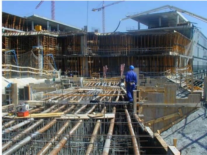
*Colocación de los cables de pretensado*
