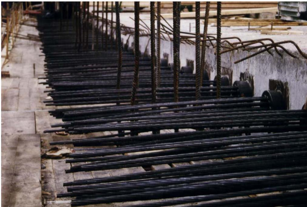
*Anclajes de pretensado en extremo de losa*
