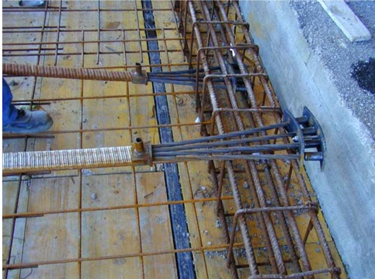
*Detalle de anclaje pasivo antes de su colocación*
