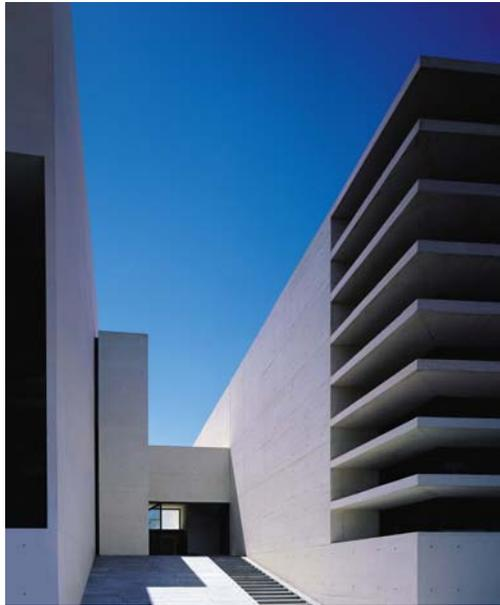
El resultado final de todos los elementos de hormigón blanco se debe al cuidadoso tratamiento de los encofrados, la disposición y coincidencia de los paneles, el sellado de latiguillos con discos de acero inoxidable y la decisión de no utilizar juntas de dilatación en los muros.
